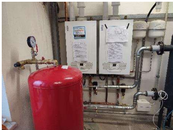
Nový zdroj tepla z 2x plynový KK
